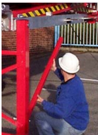
Fig. ML-22: Diagonalernes monteringspositioner på bundrammen
