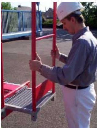
Fig. ML-44 Montering af sikkerhedsgelænder
