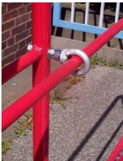
Fig. ML-48: Forbind ringskruen med sikkerhedsgelænderet.
